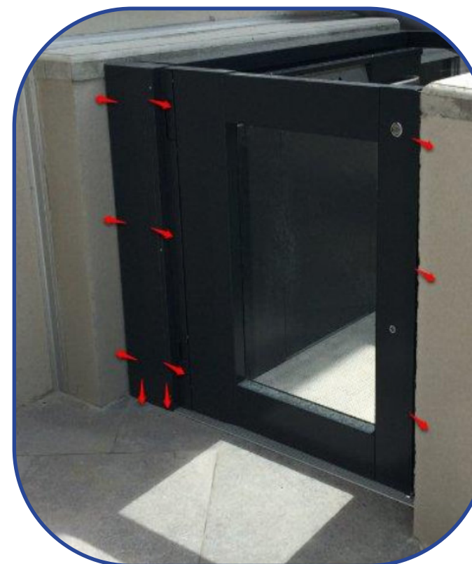
Fixation caisson + portillon niveau haut
