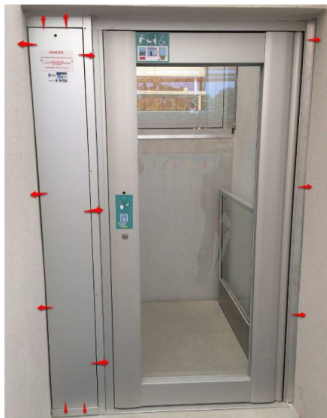
Fixation trappe machinerie + porte niveau bas
